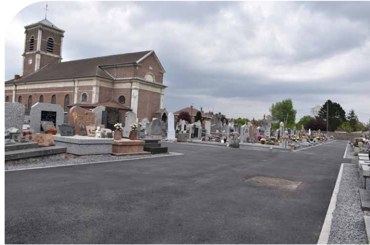
Pose d'enrobé dans les allées de l'ancien cimetière
