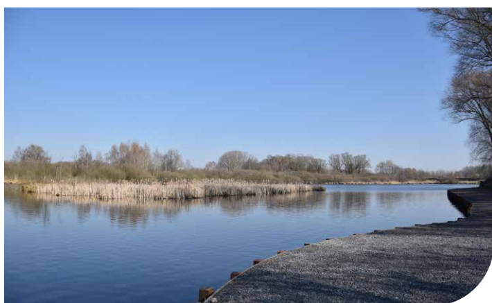
Réfection des berges au Clair des Tourelles
